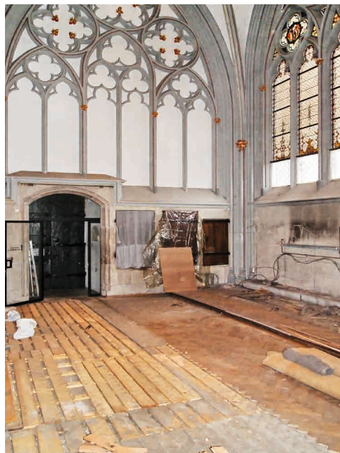
2. Obere Sakristei St. Gereon nach Norden während der Entfernung des Holzfußbodens 2010. Foto: Martin Claßen, Köln, 2010
